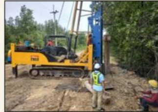
ตรวจสอบสภาพ/ซ่อมบำรุงเครื่องยนต์
